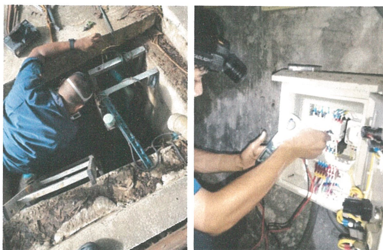
รูปภาพที่ 2.22 การดูแลและตรวจสอบระบบบำบัดน้ำเสีย
