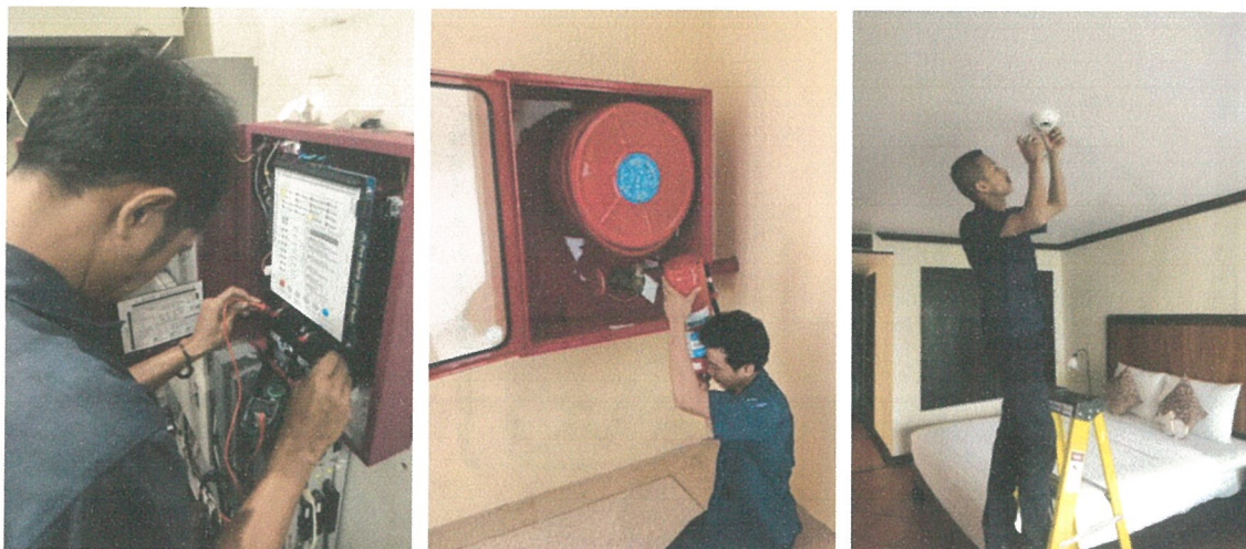
รูปภาพที่ 2.21 การตรวจสอบอุปกรณ์ป้องกันและแจ้งเตือนอัคคีภัย
